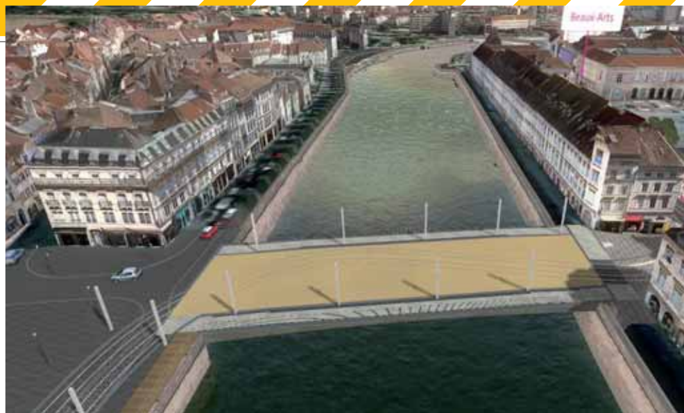
LE PONT BATTANT PLUS LARGE DE 7 MÈTRES. ↑
